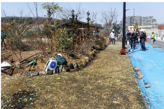
施工後、3か月後。付近の芝生が舗装内に侵入。植物の根がアスファルトの目詰まりを防ぐ。芝生を誘導し、半永久的な透水性の舗装となる。
