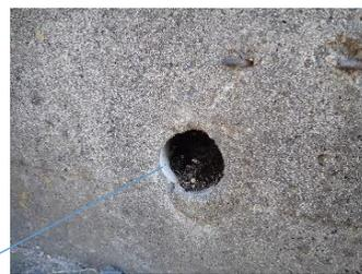
水抜き孔があるが、土砂で詰まると、通気、通水機能は著しく失われる。
