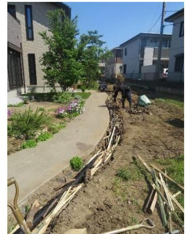
水脈を掘るラインは、空気と水の滞りやすい構造物の際、地形が変換するポイントが望ましい。ここに通気浸透水脈を整備する事により、雨水がよく浸透し、呼吸する大地となる。
