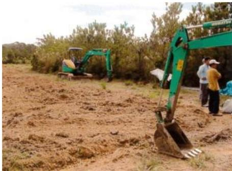
農地の外周部に素掘りの側溝(横溝)を重機で掘る。
